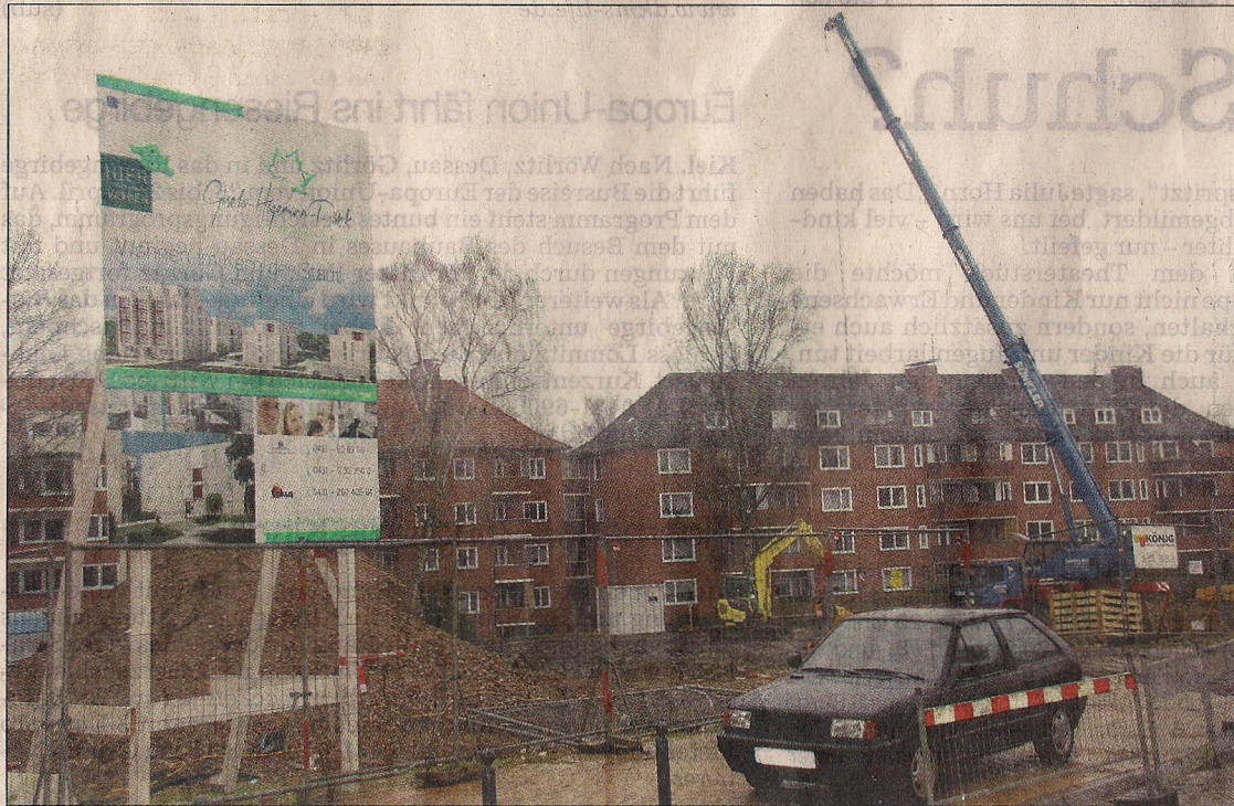
Auf dem ehemaligen Betriebshof der Gerüstbaufirma Hagemann in der Lüdemannstraße entstehen 44 neue Wohnungen. Foto kae
